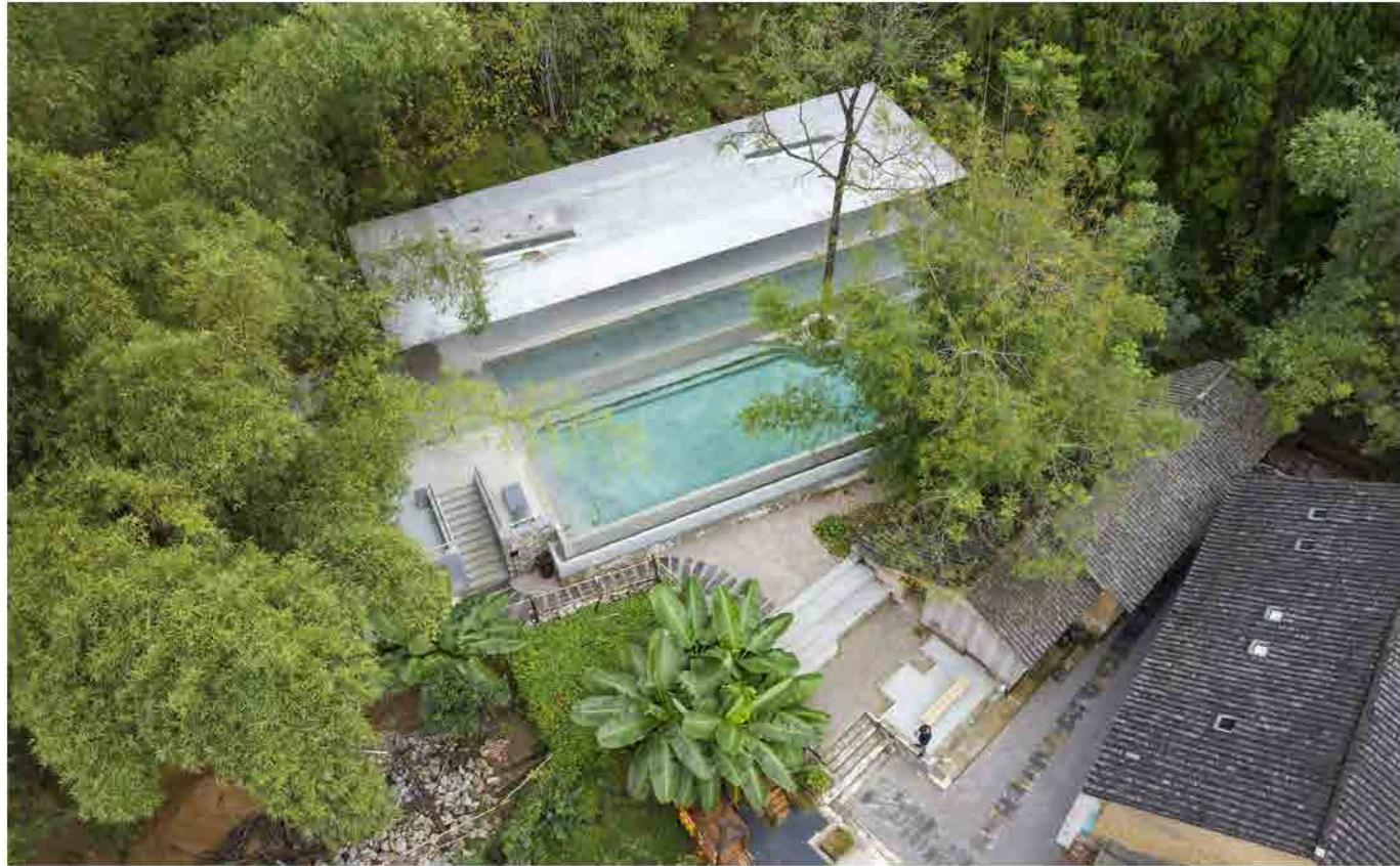
瑜伽亭以极简的方式向自然与经典致敬。钢板墙结合储藏及壁炉等多种用途，从此处望向对角线尽端，A字撑轻盈简洁地隐身于风景之中。充满视觉张力的设计，传递出瑜伽活动力与美的关联，寻求自然与自我的平衡。结构支撑部分全部用素钢板打造，经过打磨后保留的焊缝痕迹清晰可见，呈现独特的印记和纹理。在日光晴好的白日，条形天窗及锥形采光孔捕捉时刻变化的光影，带来别有洞天的惊喜。嵌入吊顶内的天花灯，带来柔和光线，夜幕下星星点点的效果又似另一重浩渺星空。游泳池部分面积同瑜伽亭相当，低处为
