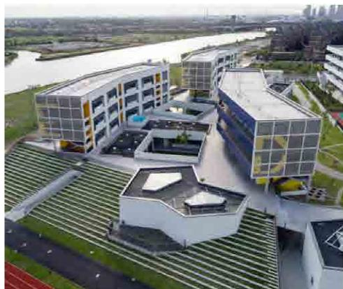
同济大学附属实验小学位于上海嘉定区安亭新镇，主体建筑群主要由教学楼、综合楼、餐厅、体育馆、架空连廊等几部分组成。设计延续了原有基地的建筑肌理，根据学校功能空间动、静的需求，通过不同尺度、不同开敞程度的庭院、廊道和运动场，将教学、办公、运动空间串联起来，以院落空间布局的组织方式，使区
