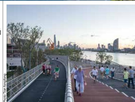
Il ponte, che supera il canale Yangjing all'altezza del fiume Huangpu, collega il Minsheng Wharf con il parco Yangjing. È un ponte a traliccio largo 10,75 m con una luce di 55 m e una lunghezza totale di 140 m. La struttura usa diverse altezze per distribuire tre flussi funzionali: biciclette, jogging e pedoni
