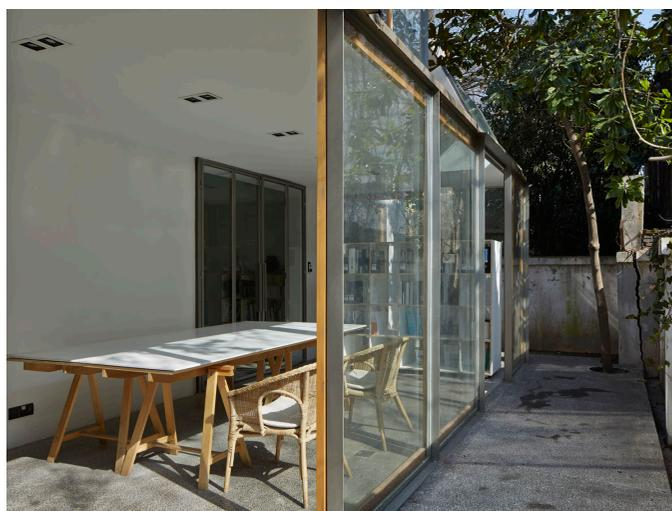
原本位于入口处的停车库地坪被抬高，改造为一间大会议室，它的双扇玻璃门可完全打开，直接通往前院和外大门，与外部的社区形成一个连续的空间界面，提供未来作为社区设计工作坊的可能性。去掉了建筑原有的过时瓷砖贴面，以纯白外墙漆、钢、木等直白的材料语言示人，看似冷淡的外表，实则突显了建筑内部的空间氛围。前院的门厅，与后院的阳光房，重新梳理整合了室内外的空间界限，大面积的落地窗，由钢框和木框分别定义了固定扇和推拉开启扇。通透的分隔明确了边界，同时又加强了室内外的联系。
