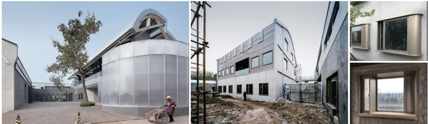
12 自由落水后强调屋面的完整性 13 保温规范下推导出独特立面 14 细节精致的窗户外
